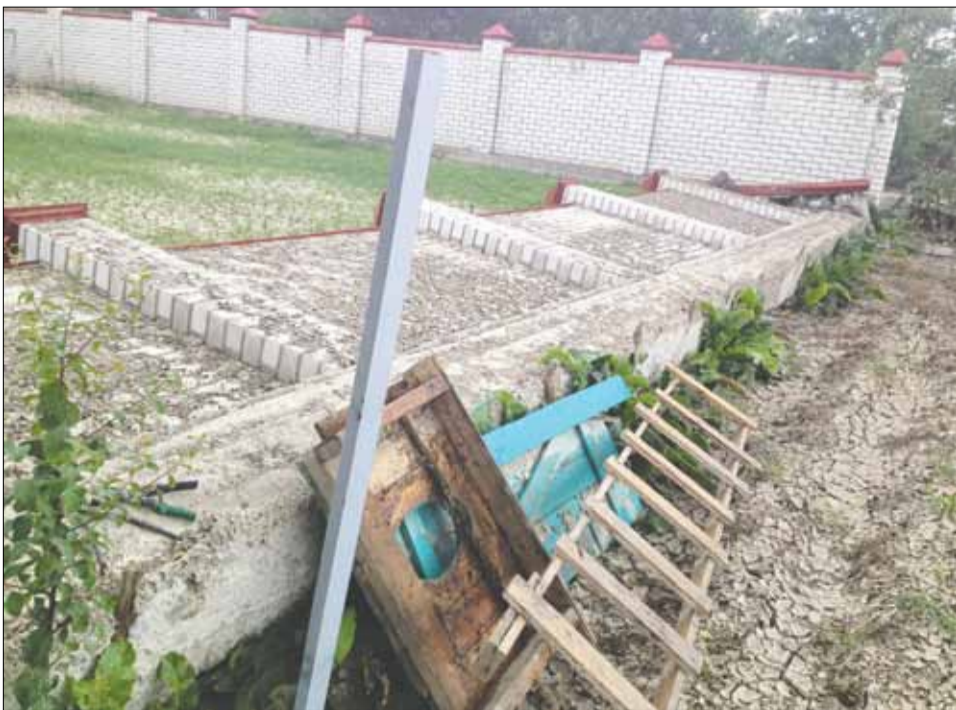
По этой фотографии можно составить представление о силе волны, выворотившей кирпичный забор вместе с фундаментом
